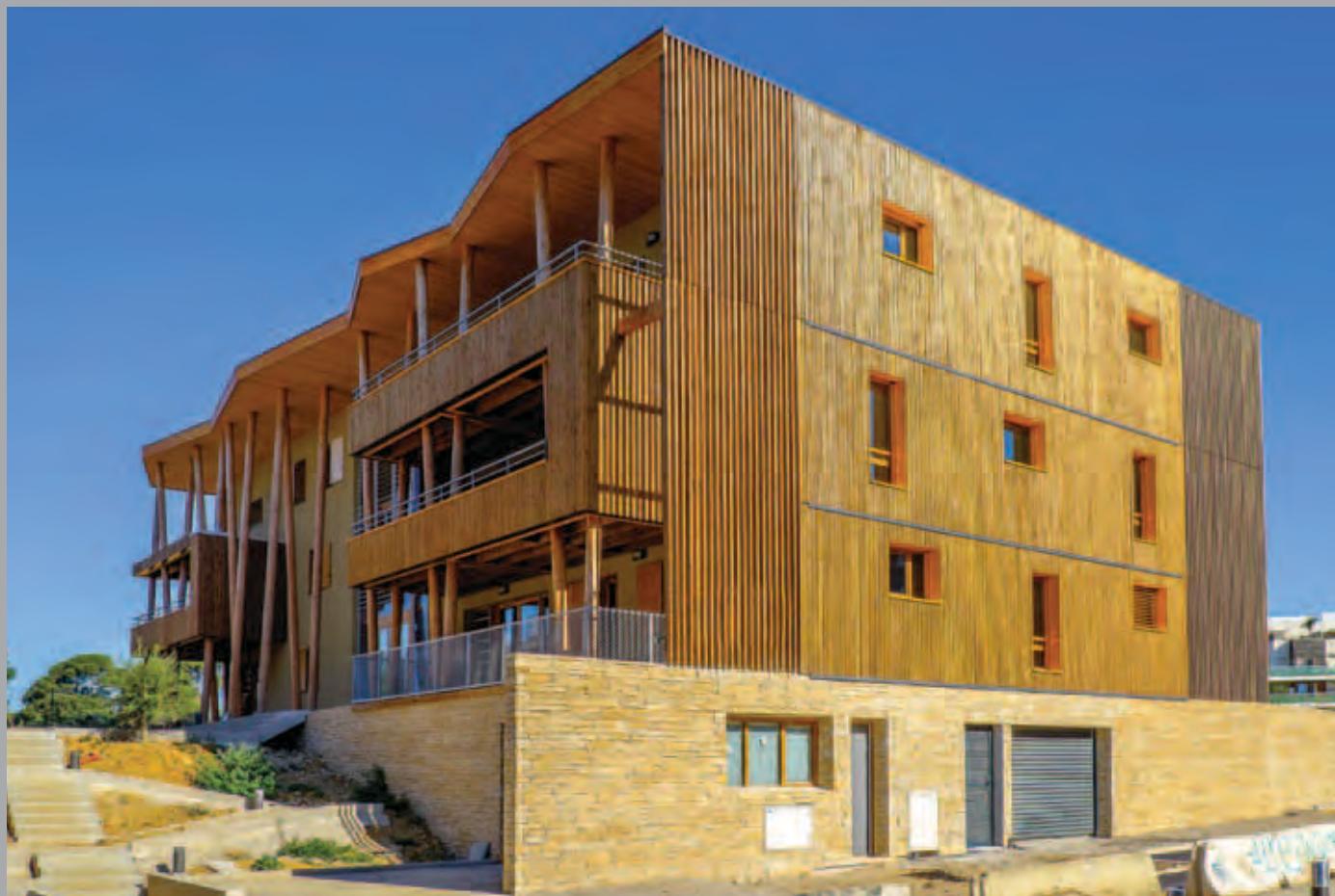
Bâtiment B : façades sud et est. Au rez-de-chaussée à gauche, la porte et la fenêtre de la salle polyvalente.
