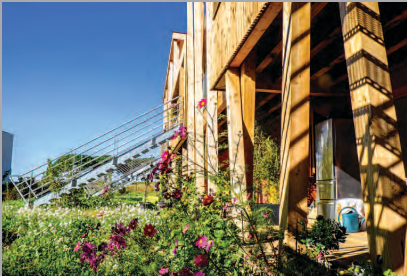
Le jardin partagé côté sud du bâtiment A.
