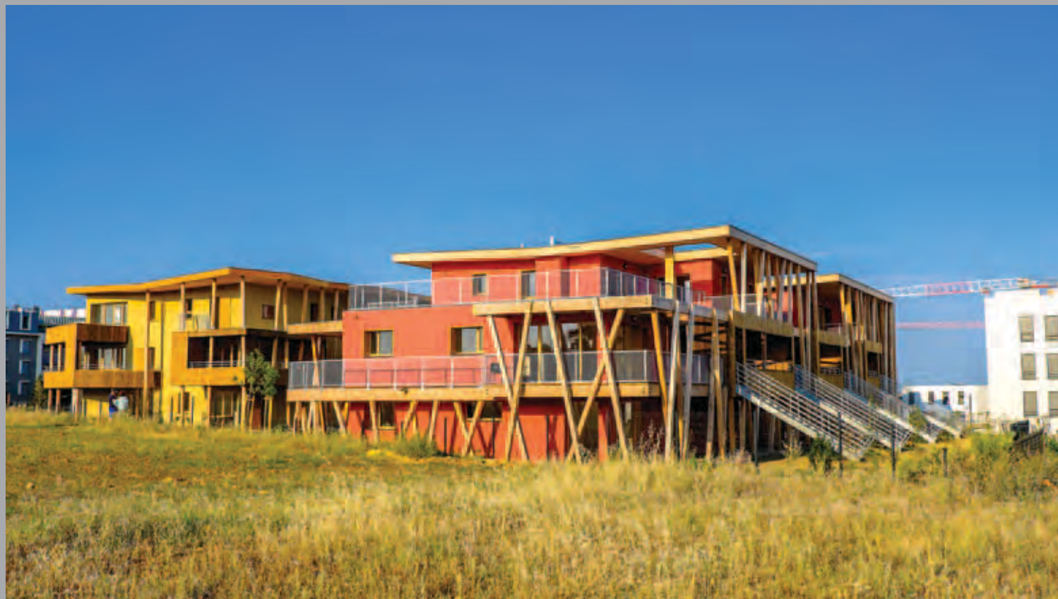
Vue d'ensemble de MasCobado. Façades sud-ouest depuis l'agriparc.
