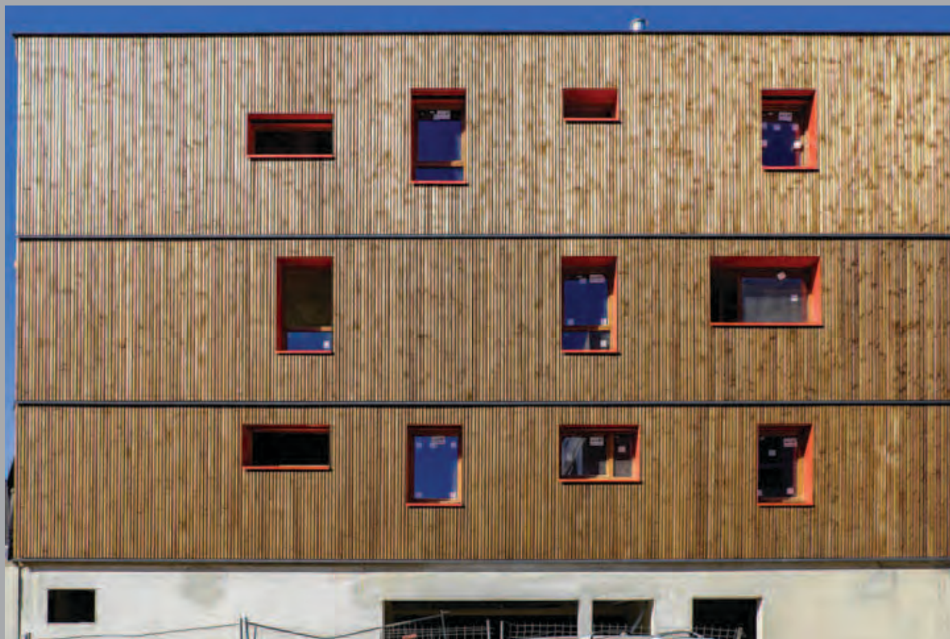
Bâtiment A : entrée du parking.
