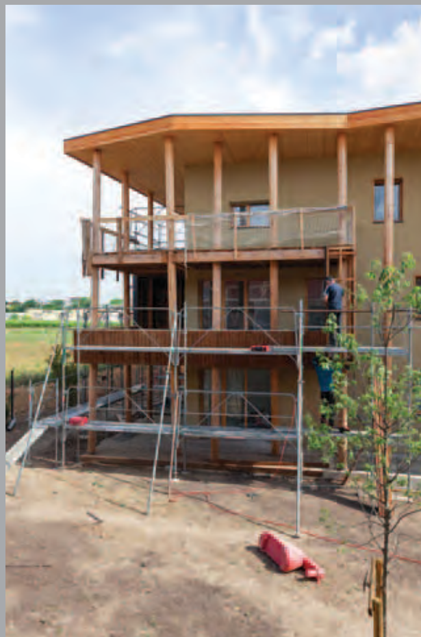
Bâtiment B : côté agriparc, les plantations font leur apparition.
