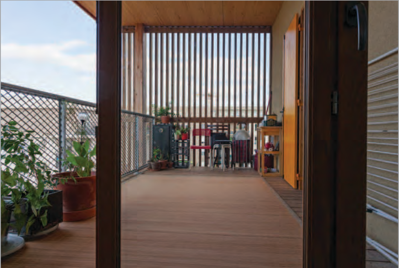
Terrasse sur laquelle donnent la chambre et le salon du logement B21.
