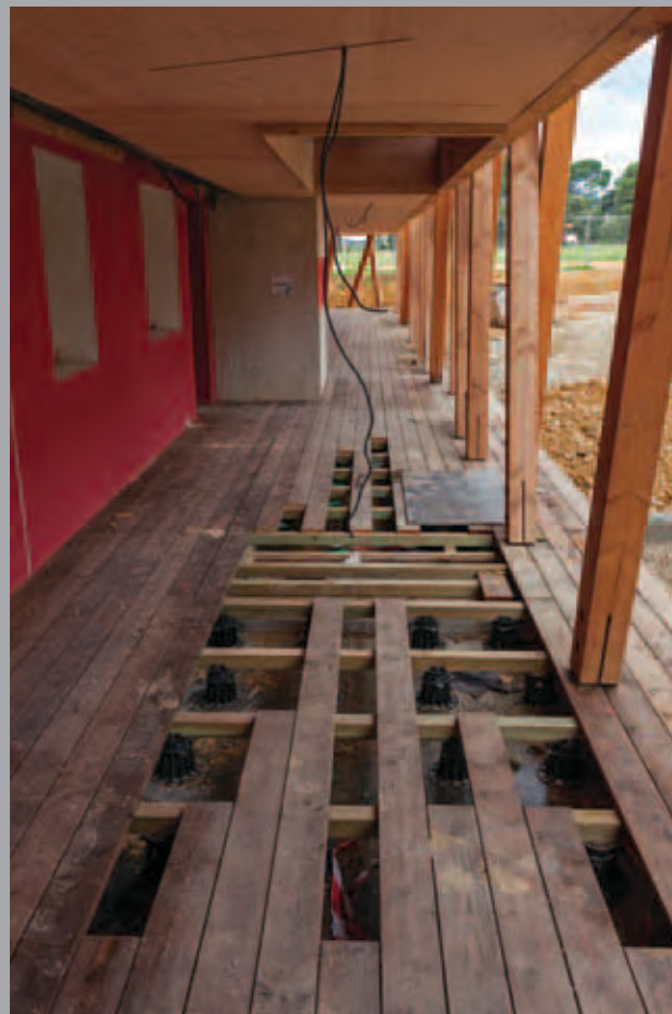
Bâtiment A : finitions du sol des coursives.
