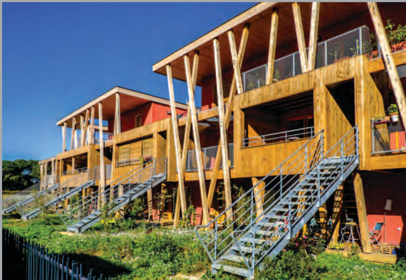
Bâtiment A : façade sud. Les terrasses privées et leurs escaliers d'accès au jardin partagé.
