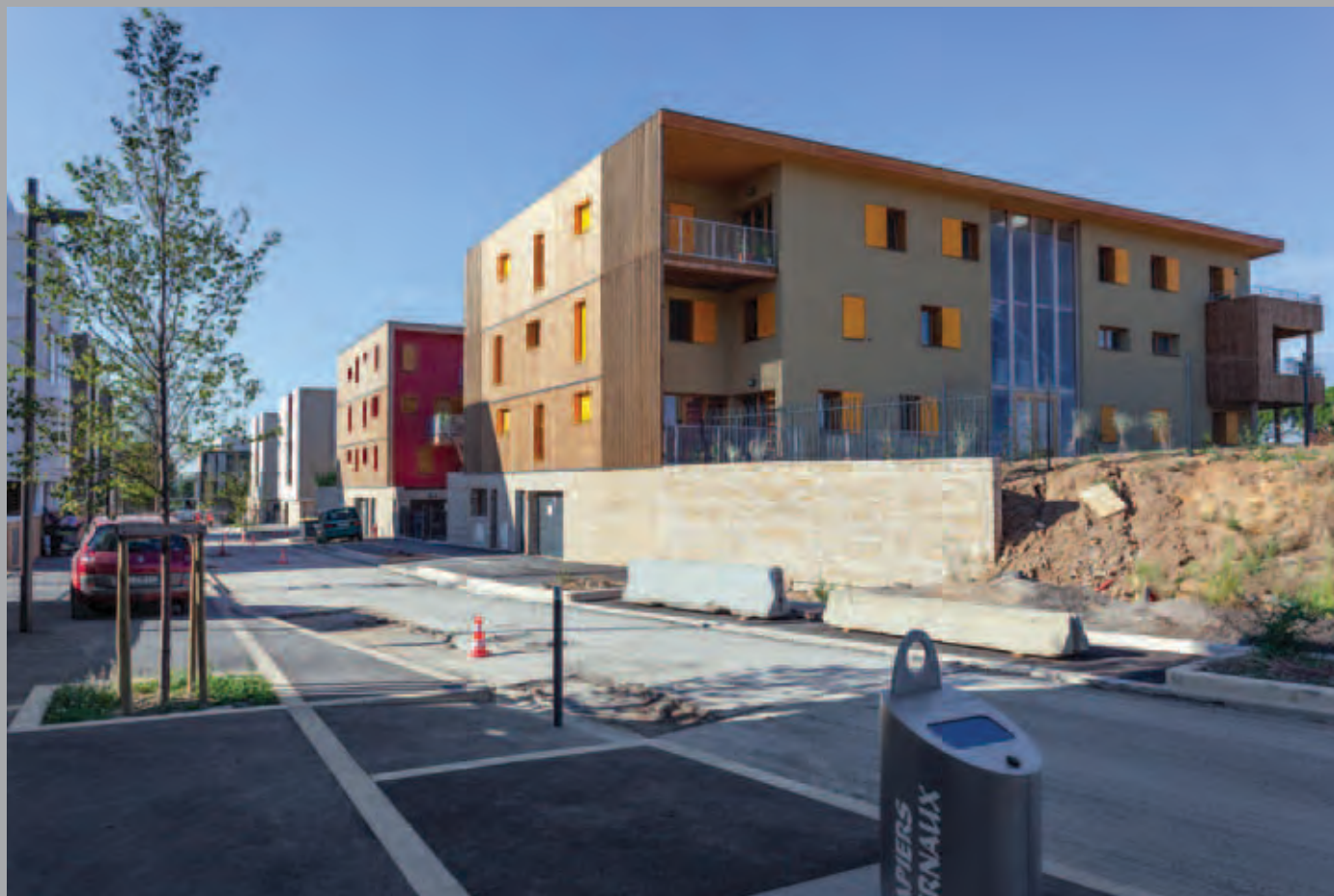
Vue d'ensemble, depuis la rue de la Réglise.
