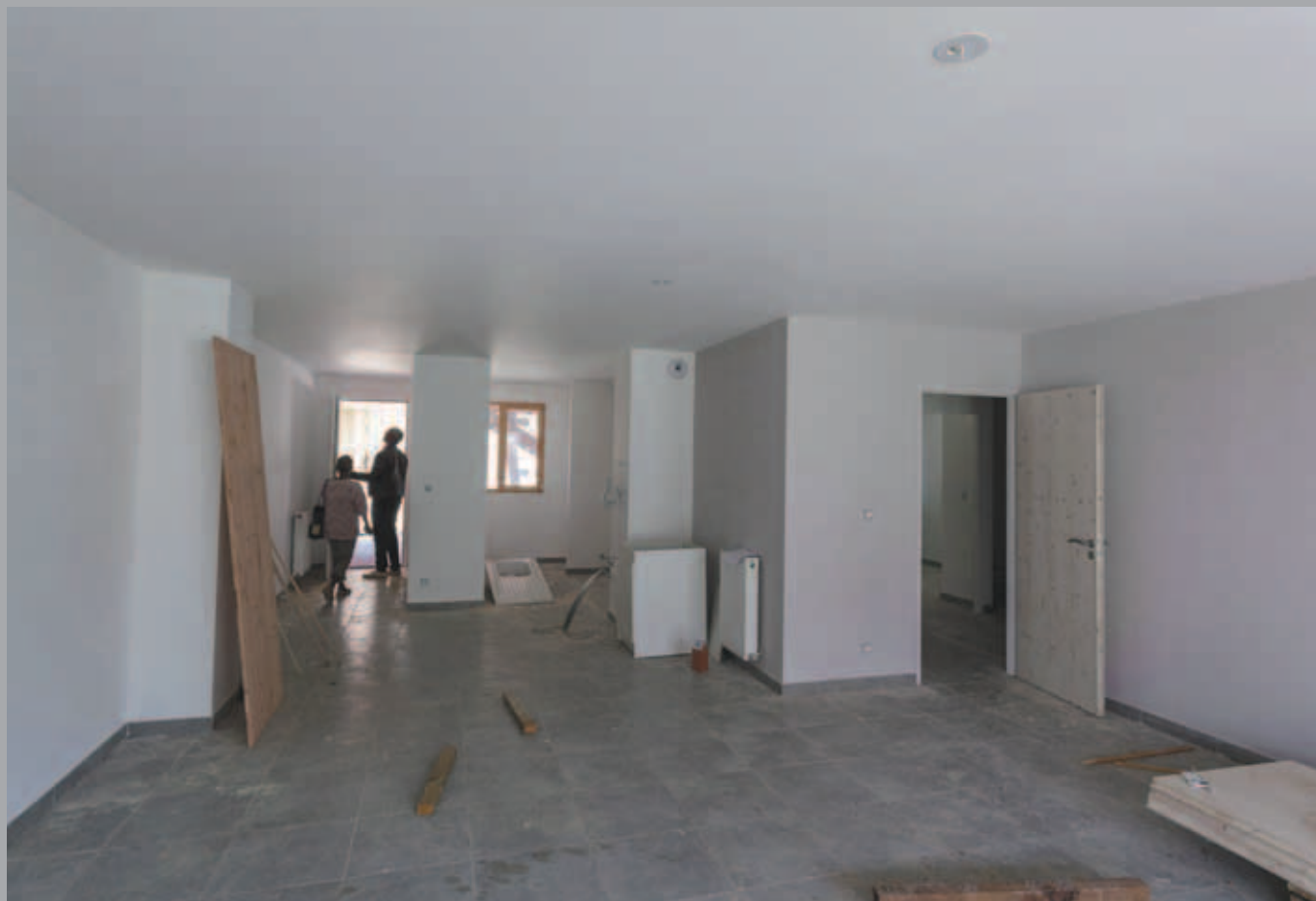
Bâtiment A : grande pièce à vivre en rez-de-jardin.
