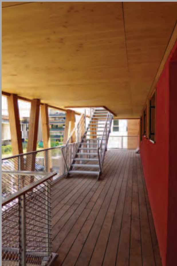
Bâtiment A : les coursives nord.
