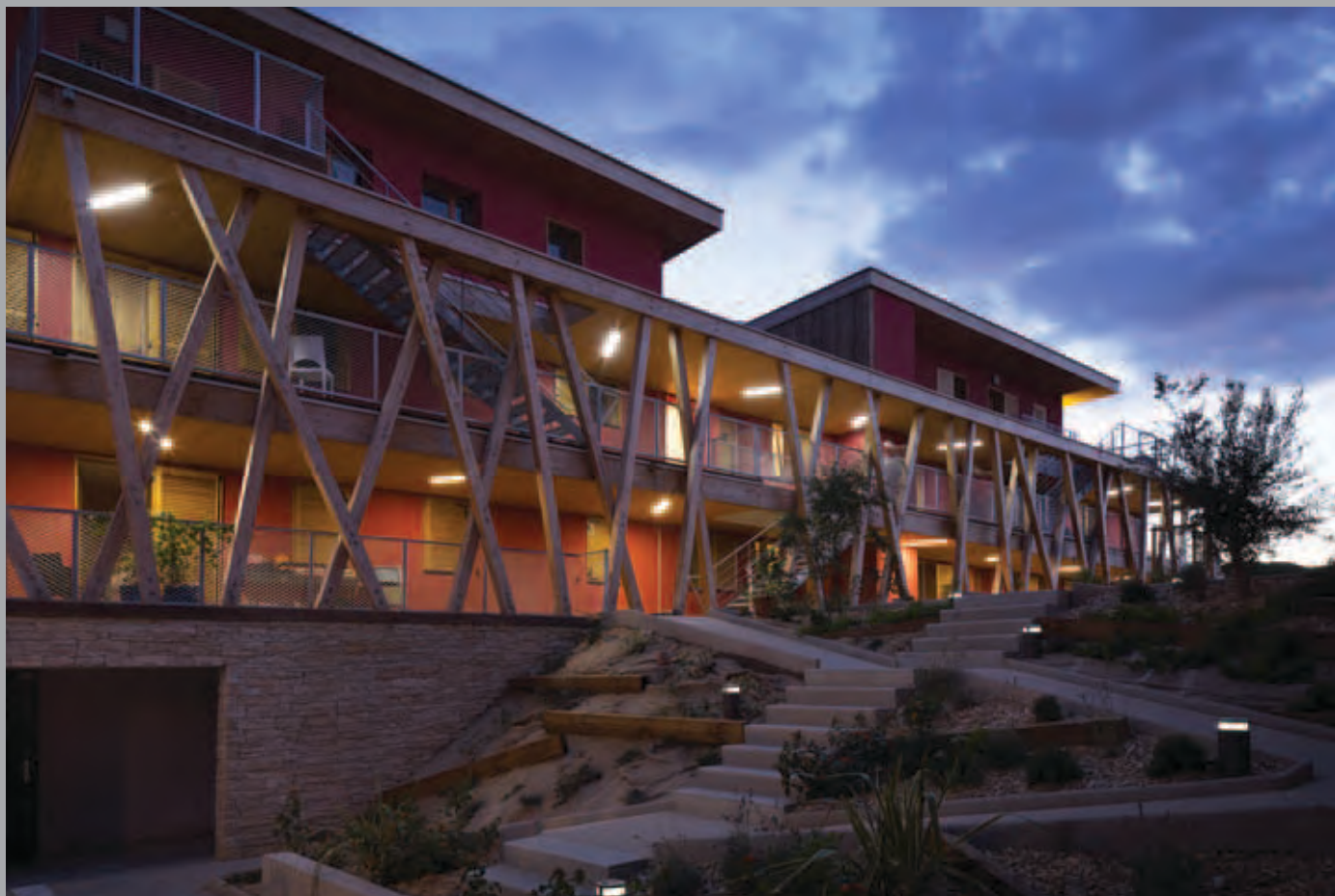
Bâtiment A : façade nord. Coursives vues depuis le parvis d'accueil. Les coursives sont éclairées par des LED agencées en écho à la résille des poteaux bois et le parvis par des plots solaires.
