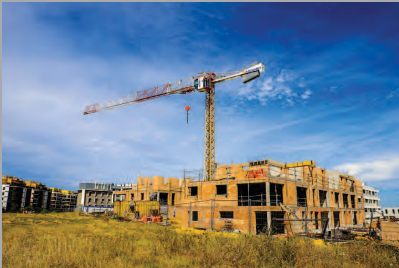
Vue du chantier depuis l'agriparc.
