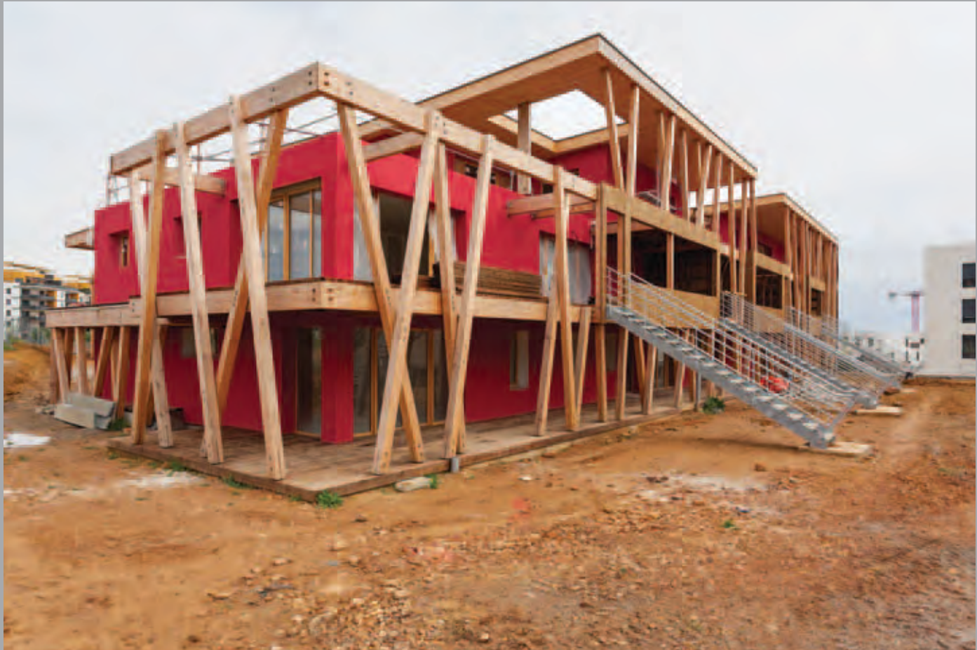
Bâtiment A : vue d'ensemble.
