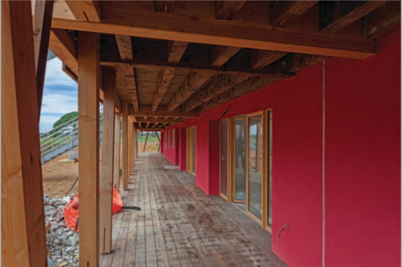
Bâtiment A : les terrasses privées du rez-de-jardin.
