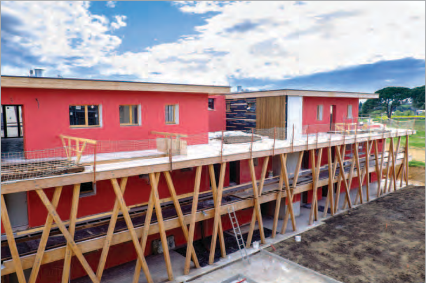
Bâtiment A : vue depuis le bâtiment B.
