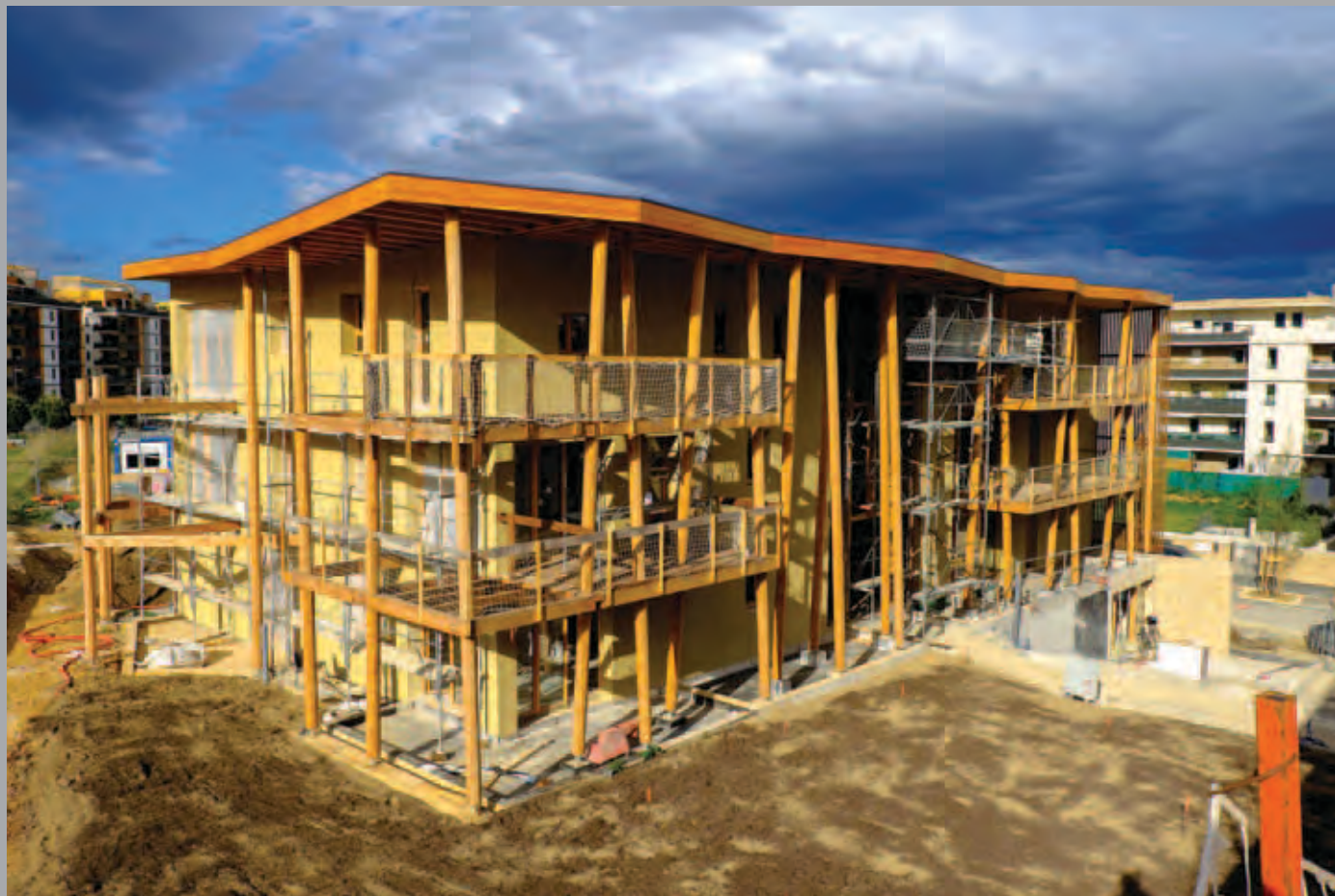
Bâtiment B : vue depuis le bâtiment A.
