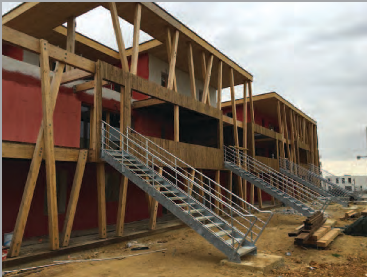
Bâtiment A : les terrasses sud et les escaliers d'accès au futur verger.
