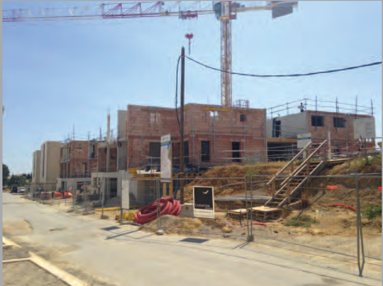
Vue du chantier depuis la rue.
