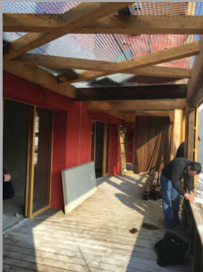
Bâtiment A : les terrasses sud.
