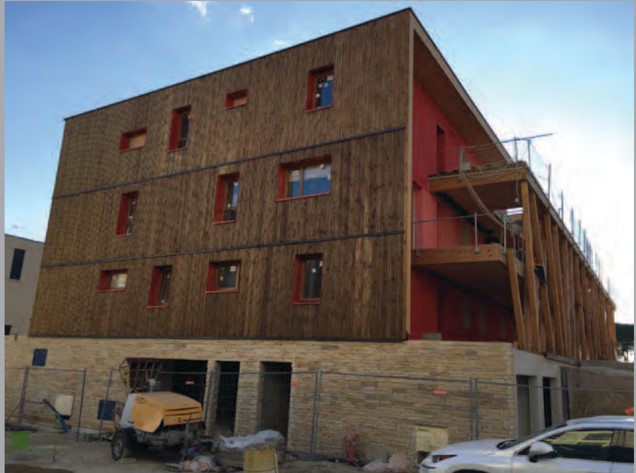
Bâtiment A : vue depuis la rue.
