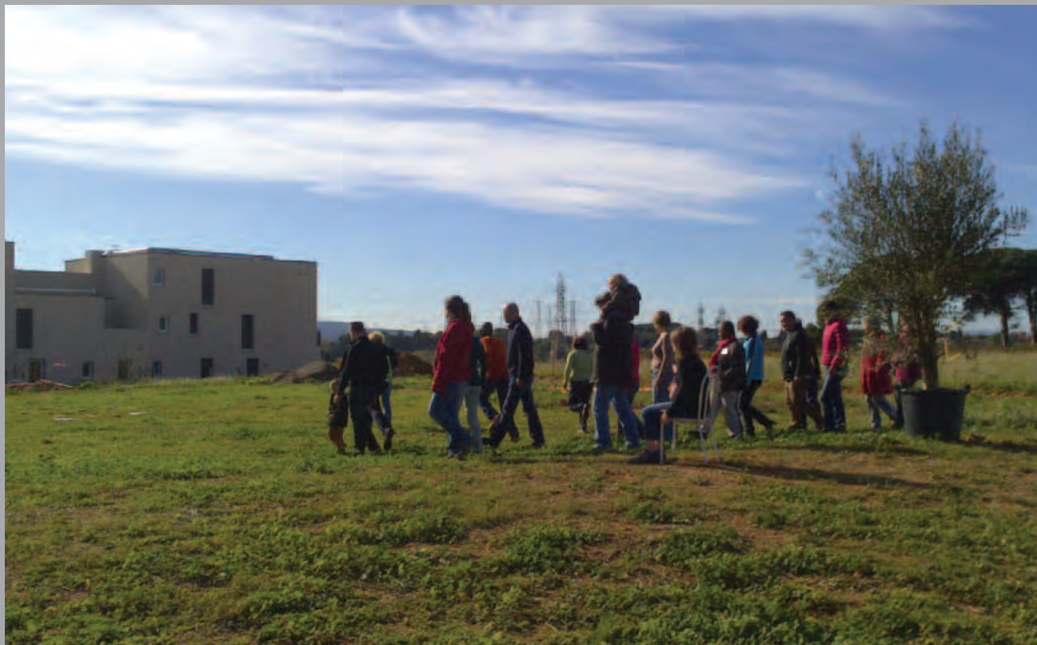
Les habitants de MasCobado lors de la pose de la première pierre.
