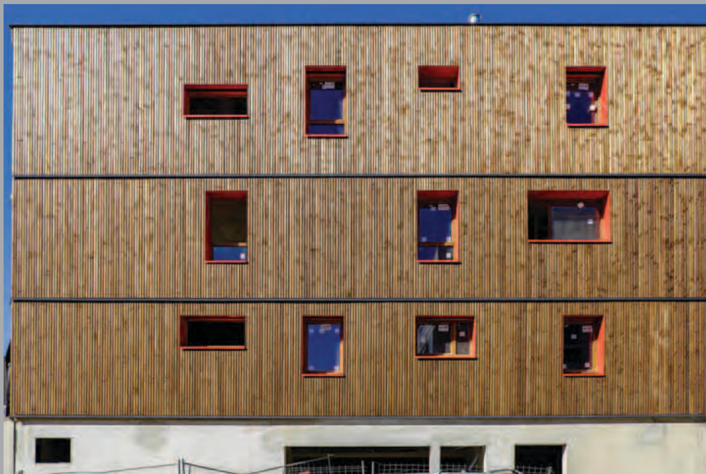
Bâtiment A : entrée du parking.
