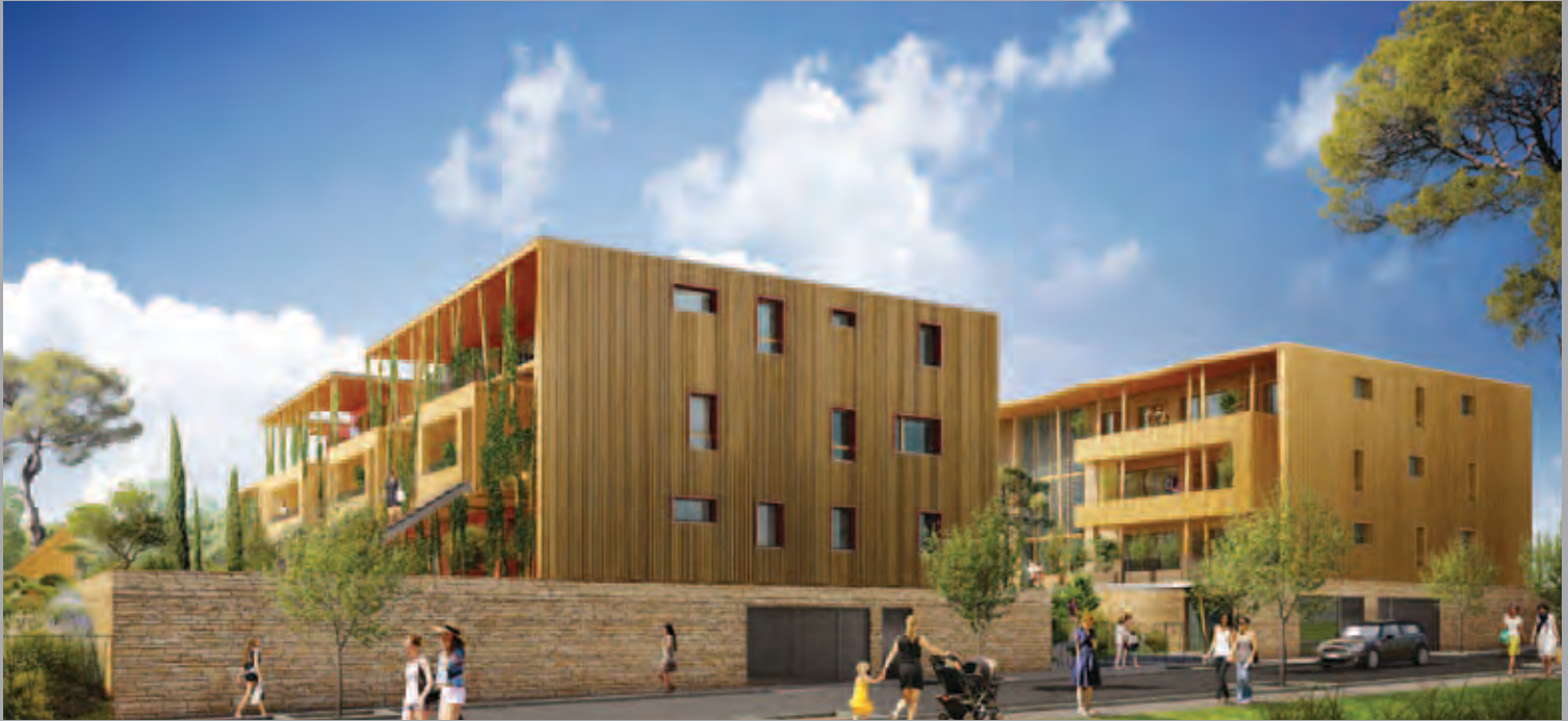
Vue d'ensemble depuis la rue de la Réglisse.
